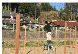
掛矢で杭打ちする江坂
