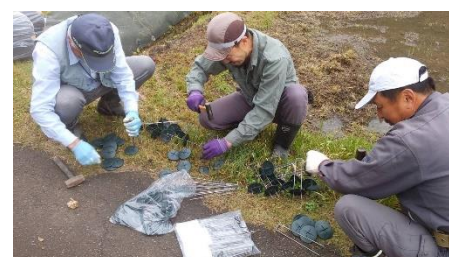
▲防草シート張り
